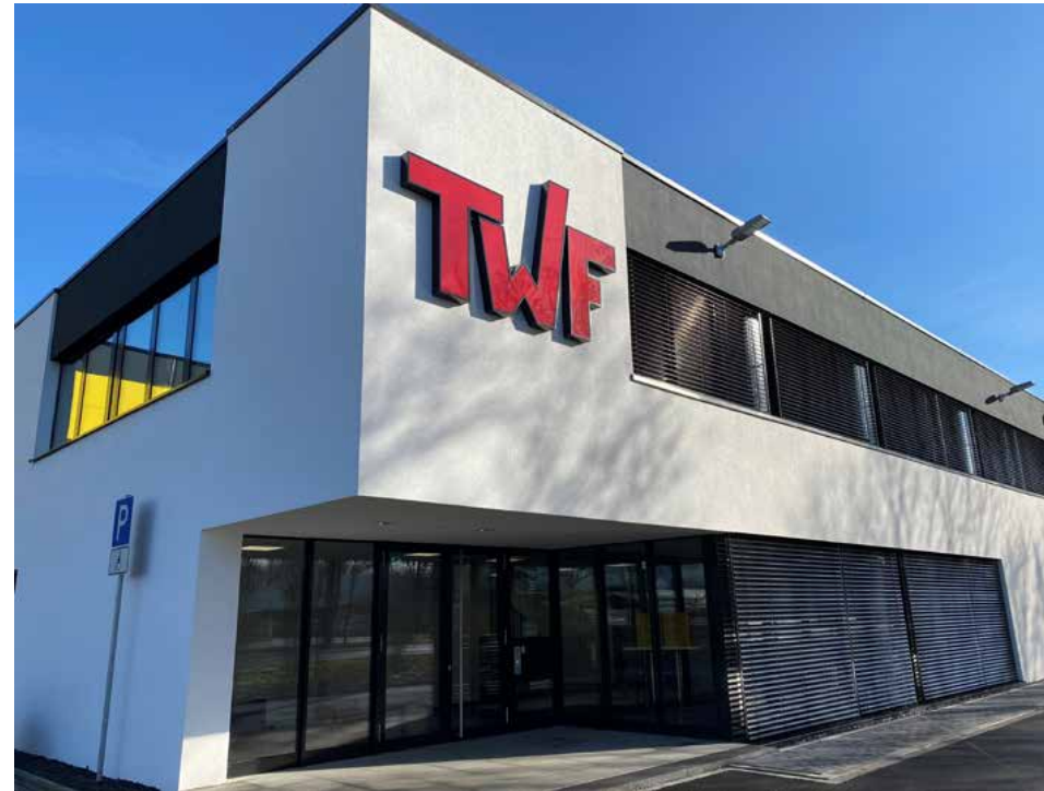
Am neuen Standort nahe der Autobahn 46 in Heinsberg baute die TWF Tiefbautechnik GmbH ihre Kapazitäten aus und ist weiter auf Expansionskurs. FOTO: TWF TIEFBAUTECHNIK
